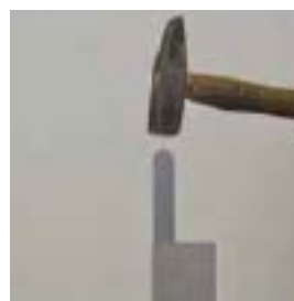
10-15 mm Tief bis zum Klemmpunkt einschlagen
