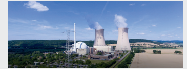
KKW Grohnde PreussenElektra GmbH
